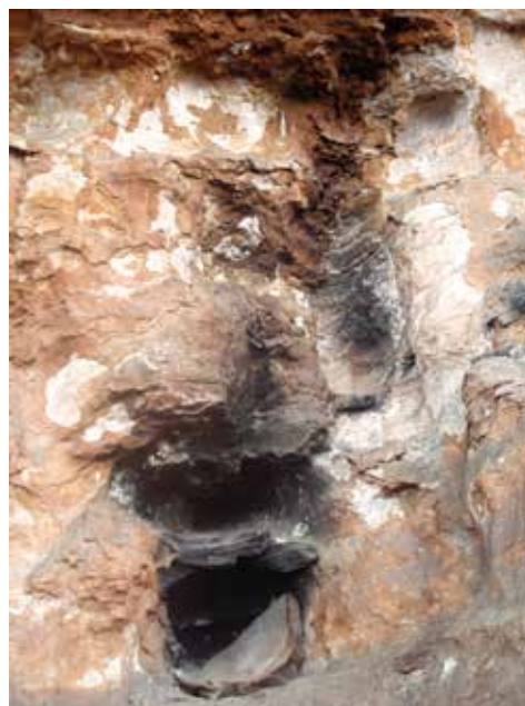
“Hotel” Basilio impactado por fogatas
